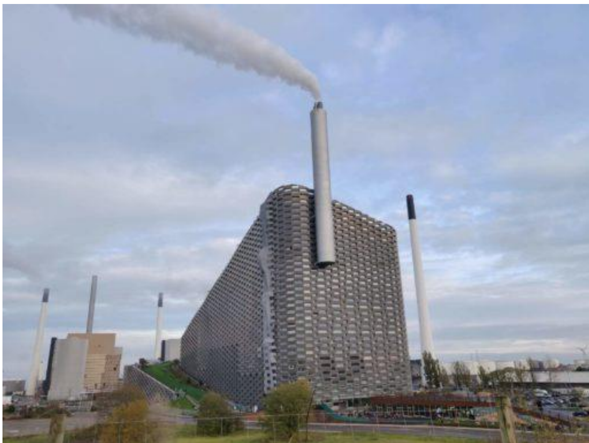
3. ábra: Modern hulladékégető 560 000 tonna éves kapacitással, Dániában (a megépítési költsége 534 000 €).
