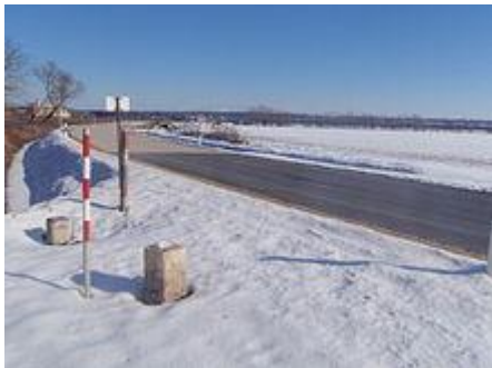
Pornóapáti - Németlövő helyreállított közúti kapcsolat a határmetszéssel
